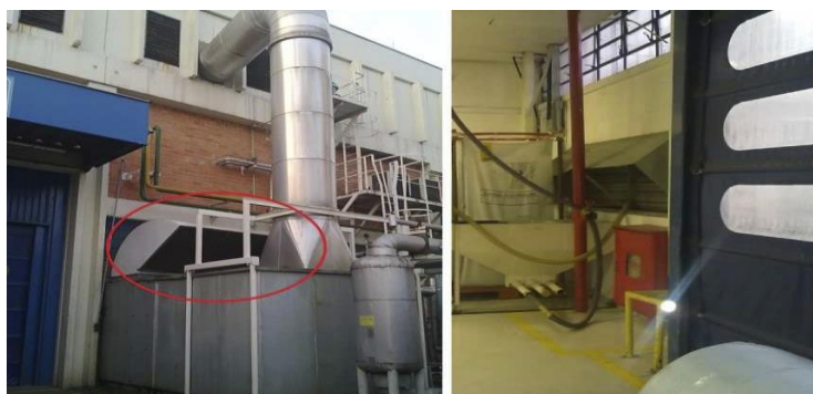
Figura 14: Esquerda: Fan coil com sua admissão de ar externa. Direita: Admissão de ar interna.
