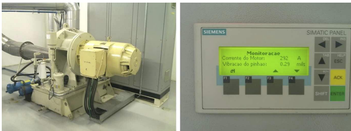
Figura 17: Compressor Centac da Ingersoll Rand à esquerda e painel seu de controle à direita.
